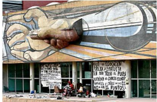
► El calor y el humo desprendidos por las fogatas que han encendido los inconformes podría causar afectaciones al mural de Alfaro Siqueiros.
