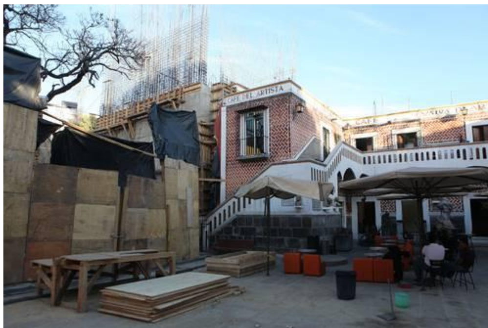
TRAS LA ORDEN DE SUSPENSIÓN DE LAS OBRAS DEL TELEFÉRICO, LAS INSTALACIONES FUERON ABANDONADAS TEMPORALMENTE. FOTO JOSÉ CASTAÑARES/ LA JORNADA DE ORIENTE
