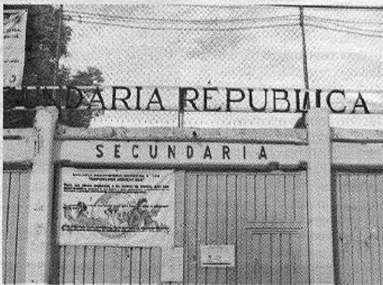
Fachada de la escuela secundaria República Argentina.
