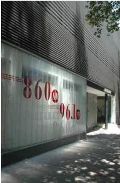
Fachada actual de la estación
