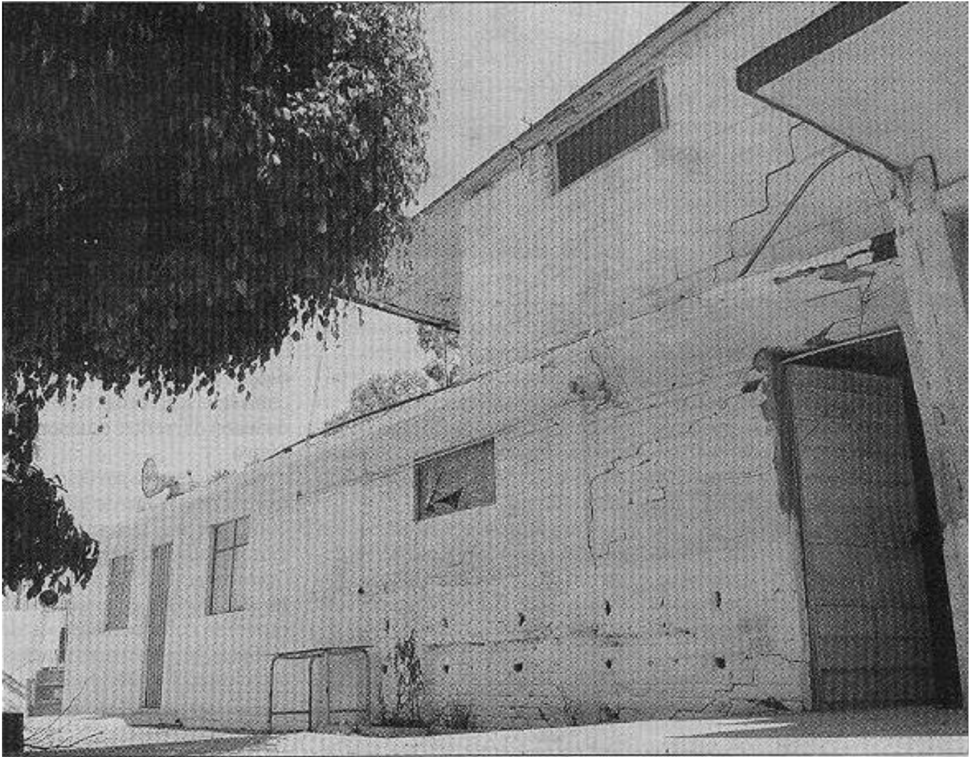
AFECTACIÓN. La escuela República de Madagascar, en Iztapalapa, será demolida en su totalidad.
