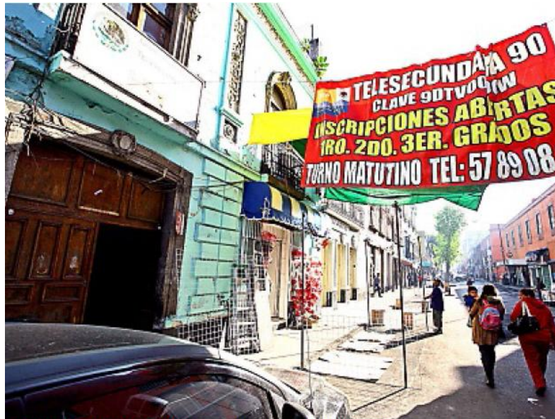
GOLPE A LA EXCELENCIA. La Telesecundaria 90 obtuvo en 2011 el mejor puntaje en matemáticas de la Prueba Enlace, pero ahora el inmueble está en riesgo por una falla en el subsuelo.
