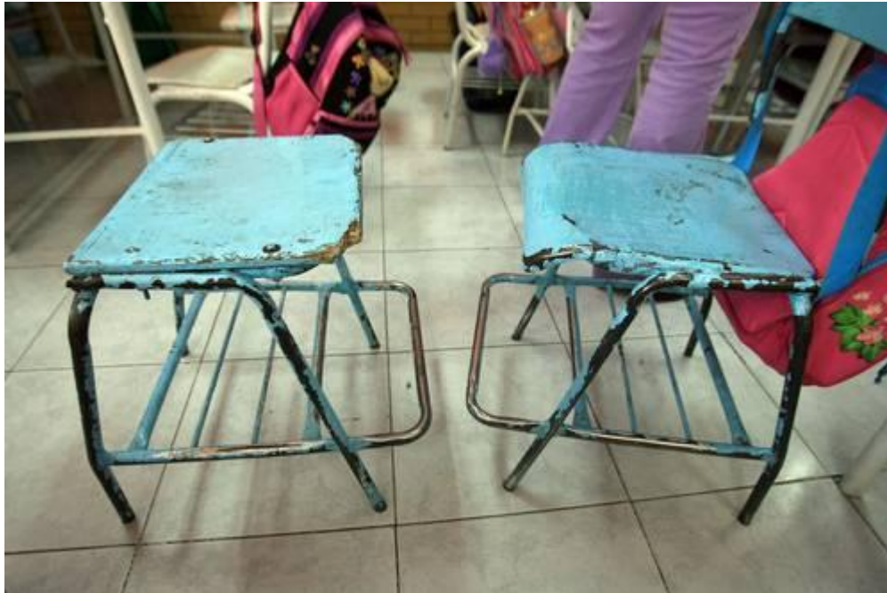
DETERIORO DEL MOBILIARIO EN LA ESCUELA JOSÉ MARÍA LAFRAGUA, EN IZTAPALAPA. FOTO JESÚS VILLASECA
