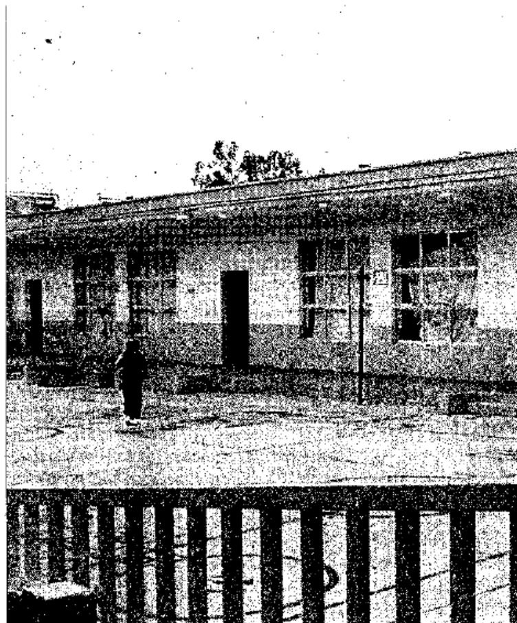
» ESCUELAS EN Iztapalapa carecen de agua en sus instalaciones.
