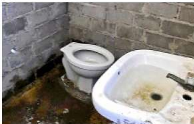
> Con el gasto de la SEP, arrancará la construcción de los baños y una cisterna en la secundaria.
