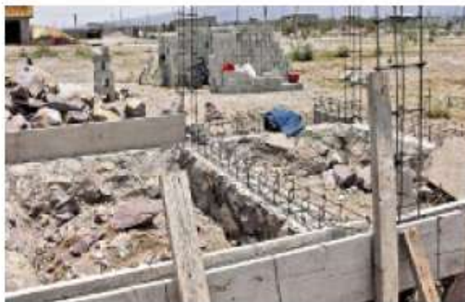
> En la primaria Ticic, de Valle de Chalco Solidaridad, inició la construcción de baños y de una fosa séptica.
