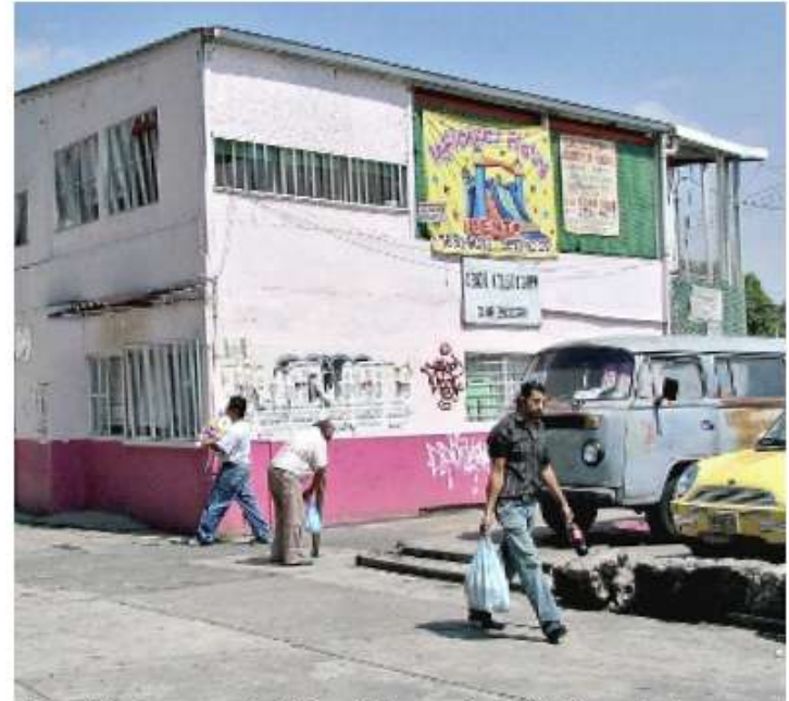
> La salida de emergencia del Cendi del mercado de Villa Coapa da al estacionamiento, el cual es ocupado por puestos durante varios meses al año.
