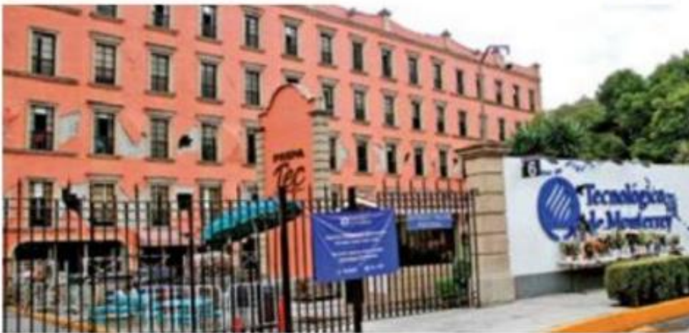
VULNERABLE. El edificio correspondiente a la preparatoria del Tec fue dañado fuertemente durante el sismo del 19 de septiembre, por lo que la institución prevé demolerlo.
