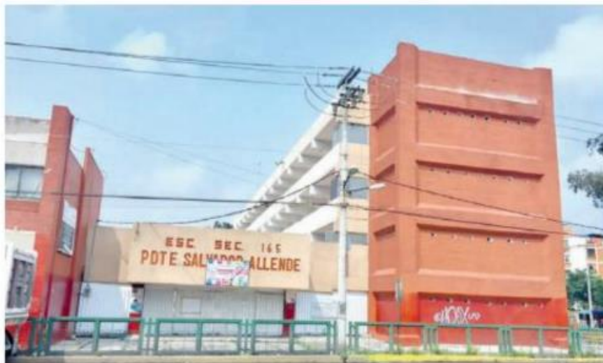
Aún faltan centros escolares por ser reparados /DANIEL HIDALGO
