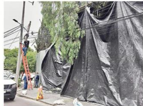
Trabajadores realizan últimas labores también en lo que será la plaza Distrito Pedregal.
