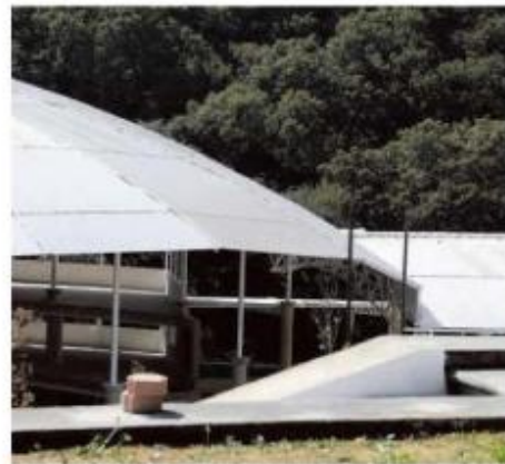
Por pandemia se suspendieron las obras
