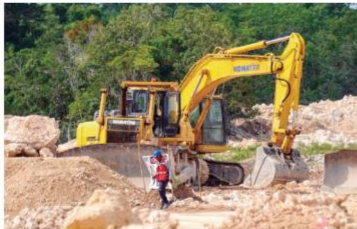
OBRAS del Tren Maya en Cancún, Quintana Roo, el pasado 11 de noviembre del 2022.
