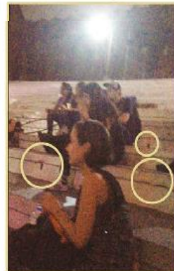
» Las gradas, donde antes había butacas, están con grietas, sucias y descapeladas.
