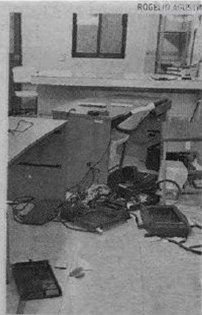
Así quedaron las oficinas.
