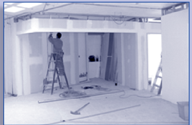
Diciembre: de piso a techo todo nuevo
